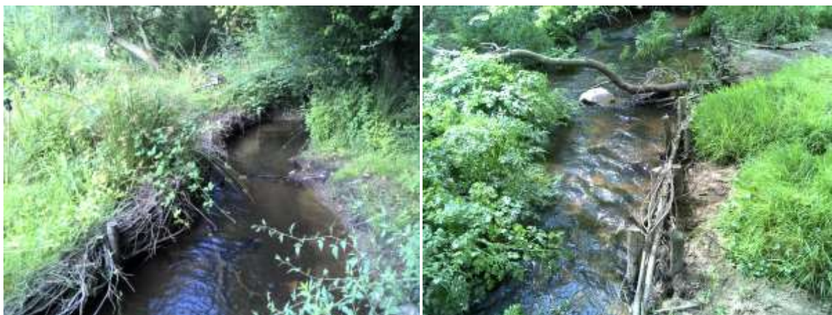
Berges restaurées sur un cours d'eau du bassin versant du Trévelo – Source : Hardy Environnement
