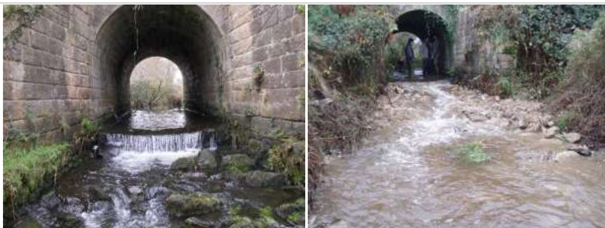
Aménagement d'une rampe d'enrochement – Source : Fédération de pêche du Morbihan
