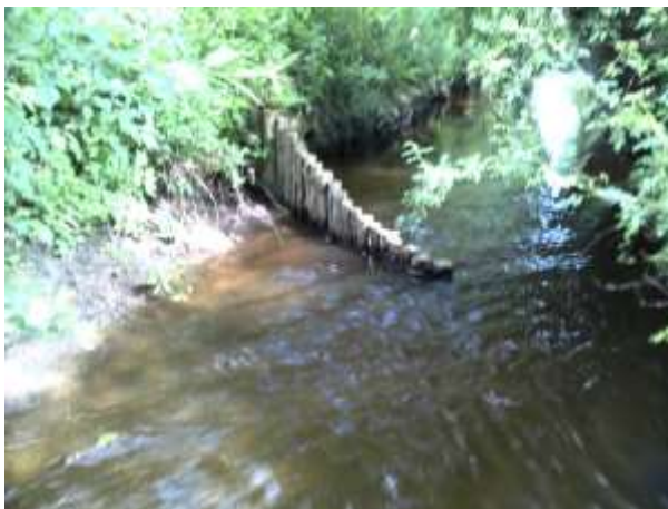
Risbermes et épis mis en place sur un cours d'eau du bassin versant du Trévelo – Source : Hardy Environnement
