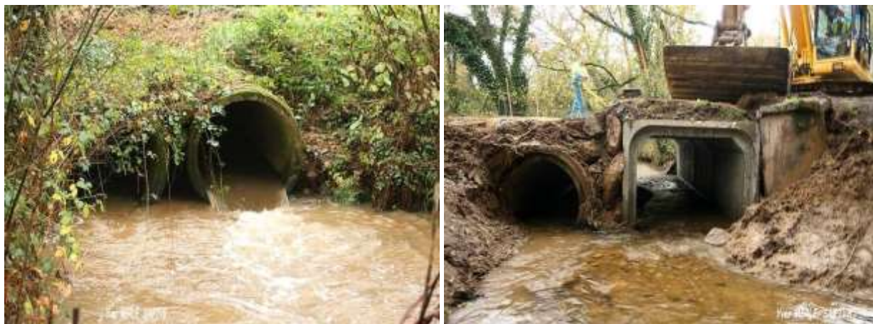
Buse recalée et ouvrage remplacé par un pont cadre sur le bassin versant du Blavet – Source : Hardy Environnement
