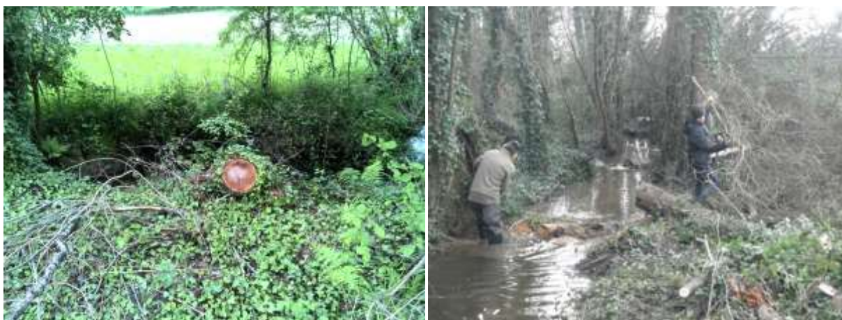
Travaux de restauration de ripisylve – Source : Hardy Environnement
