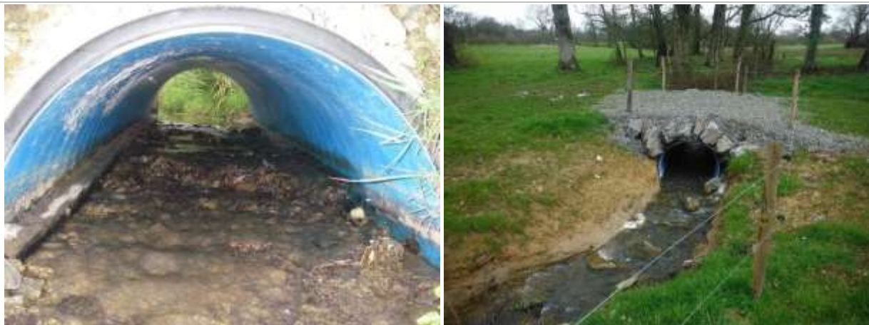
Buses remplacées – Source : Hardy Environnement
