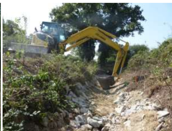
Recharge granulométrique de cours d'eau – Source : CAP Atlantique
